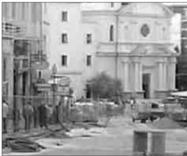
Un tratto di corso Mazzini che fu interessato dai lavori
